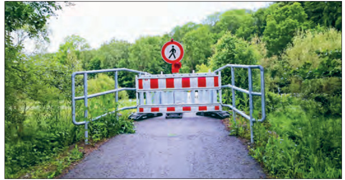
Sperrung der „Schwarze Brücke“ im Ortsteil Falkenau. Foto: E. Enew
